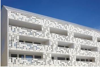
Die vorgelagerte Fassade aus strahlendem Weiß dient als raffinierter Sichtschutz und bietet durch die Perforierung eine hohe Transparenz.
