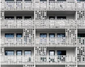
Lupenreine Fertigteile in Größen bis zu 4,57 x 1,87 m ohne sichtbare Fugen. Möglich wurde das durch entsprechend große, verschweißte alkus Vollkunststoffplatten.
