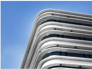
Die Fassade besteht aus der thermischen Hülle und den vorgehängten Betonteilen. Der Vorteil: hohe Eigenbeschattung und Verzicht auf einen zusätzlichen Sonnenschutz.
