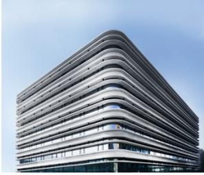
Mit 13 Schalungen wurden 1150 Fertigteile produziert. Das entspricht theoretisch 88 Teilen pro Schalung. Und das bei gleichbleibend guten Oberflächen vom ersten bis zum letzten Teil.
