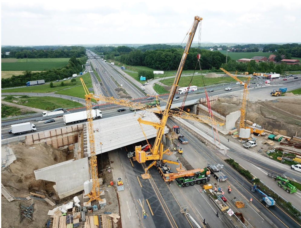
Bau der Behelfsbrücke im Autobahnkreuz Lotte/Osnabrück, © Rekera Betonwerk GmbH & Co. KG
