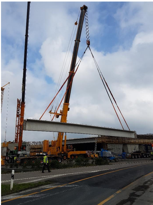
Spannbetonträger von 36 Metern Länge. Die Fertigteilform wurde mit 24 alkus ® -AL-20-Platten mit insgesamt gut 200 Quadratmetern Fläche konstruiert., © Rekers Betonwerk GmbH & Co. KG
