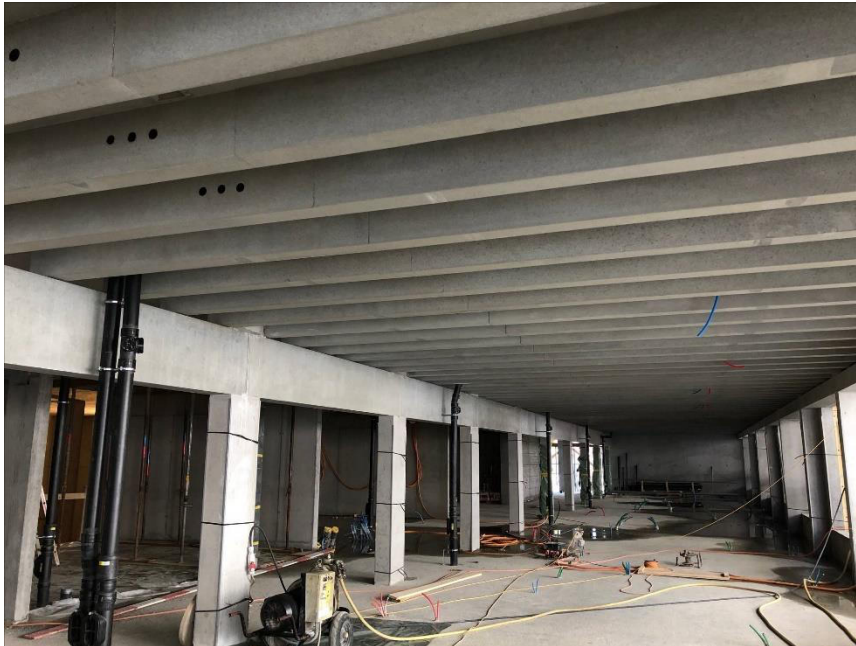
Die T-Träger-Deckenplatten im neuen Bettenhaus M des Kantonsspitals Chur. © alkus AG
