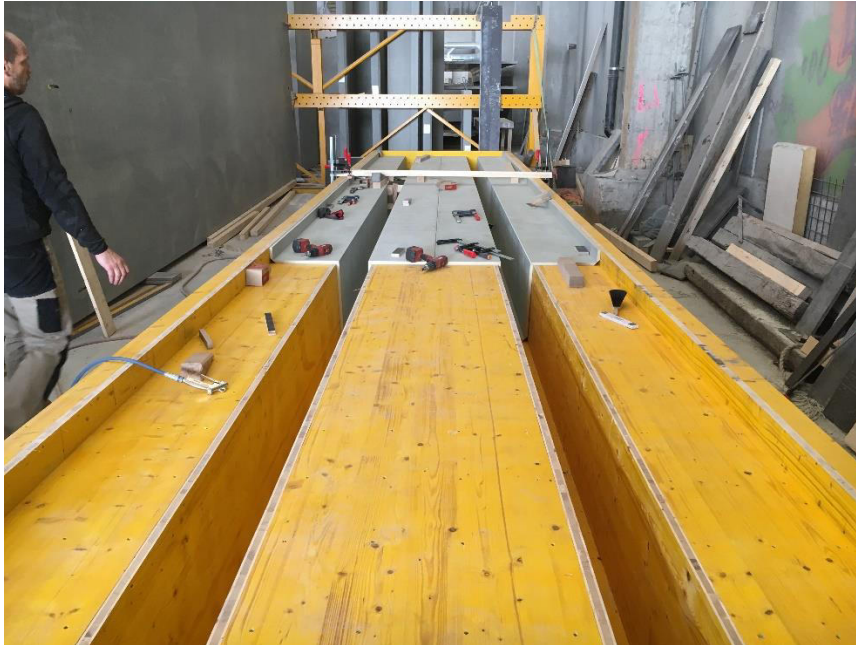
Belegung der Holzkonstruktion für die T-Träger-Deckenplatten von 12 Metern Länge mit der alkus® Vollkunststoffplatte. © alkus AG
