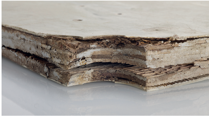
Ein grundsätzliches Problem: Holzschalplatten sind erfahrungsgemäß nach einigen Dutzend Einsätzen so abgenutzt, dass sie ersetzt werden müssen.
