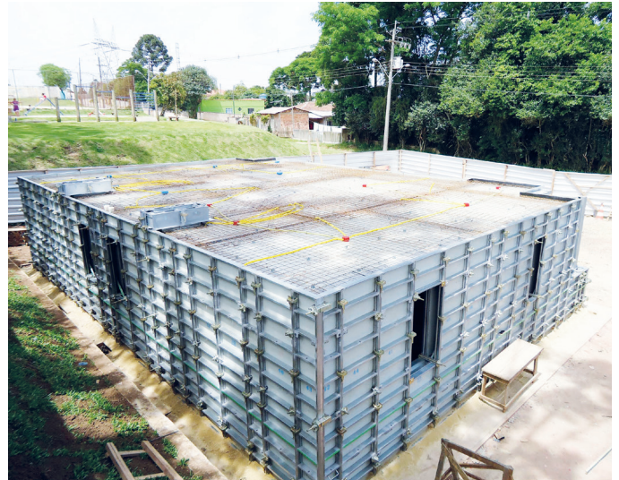
Bürogebäude Tic Tric Trac in Zürich (li.) und Wohnungsbau in Brasilien (re.): Der Einsatz von Kunststoffschalhaut kann bei Großprojekten genauso sinnvoll sein wie bei weniger spektakulären Bauten.
