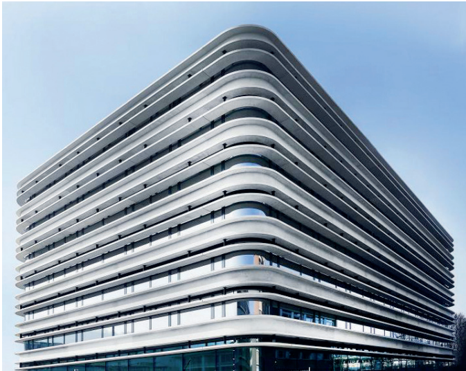
Bürogebäude Tic Tric Trac in Zürich (li.) und Wohnungsbau in Brasilien (re.): Der Einsatz von Kunststoffschalhaut kann bei Großprojekten genauso sinnvoll sein wie bei weniger spektakulären Bauten.
