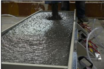
Betonieren mit selbstverdichtendem Beton (SCC) – das System konnte dem Druck problemlos standhalten.
