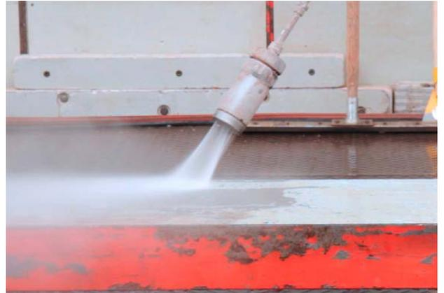
Minimaler Abstand bei Druck: >30 cm Max. 1000 bar
