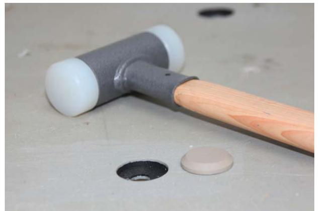
Reparaturplatte (siehe Seite 9) einlegen und mit einem Plastikhammer in das Loch einschlagen.
