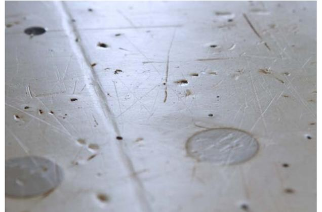
Überstände von Nagellöchern und kleinflächige Verschmutzungen können ebenfalls mit dem Farbkratzer schnell und einfach beseitigt werden.
