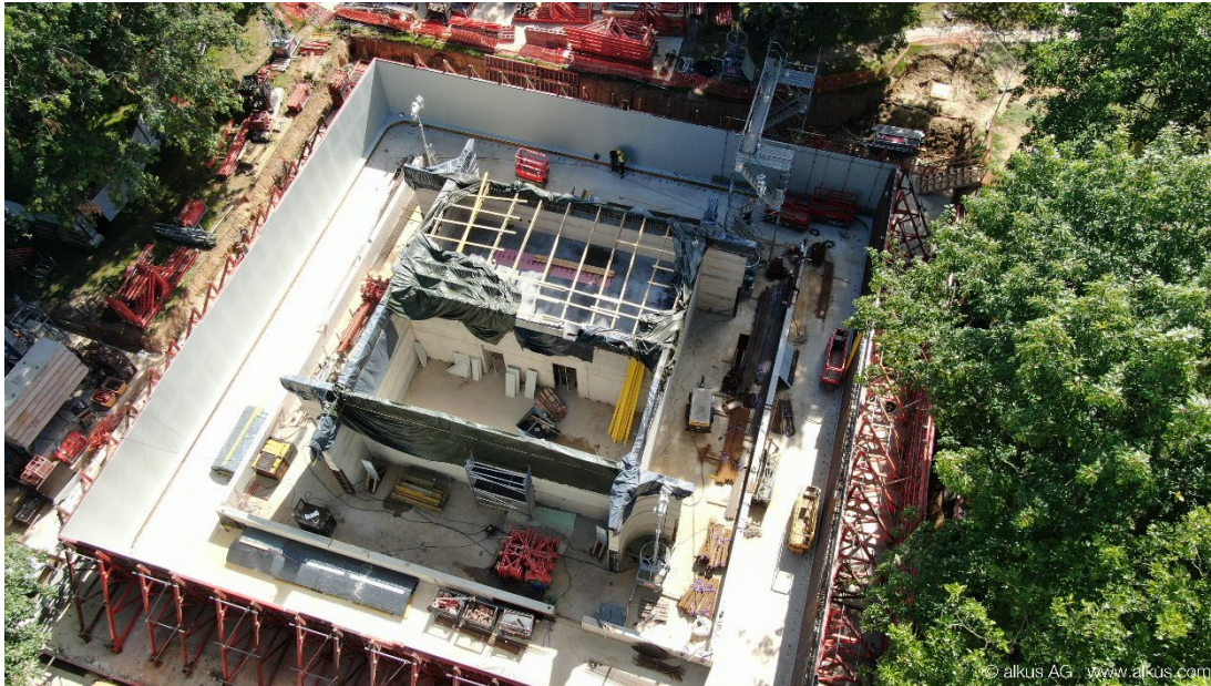
Bild 6: Fascia mit ebenfalls abgerundeten Ecken.
