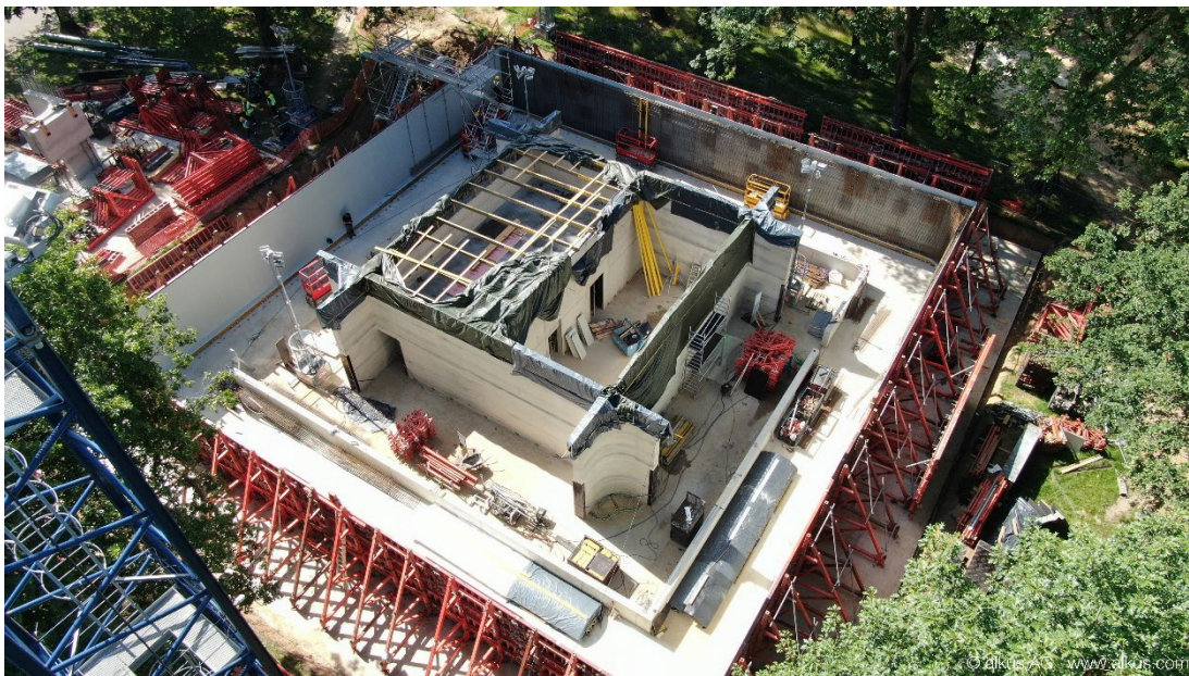
Bild 5: Fascia 30x30x4m. Die Wände wurden ohne Verwendung von Ankerstäbe fixiert.
