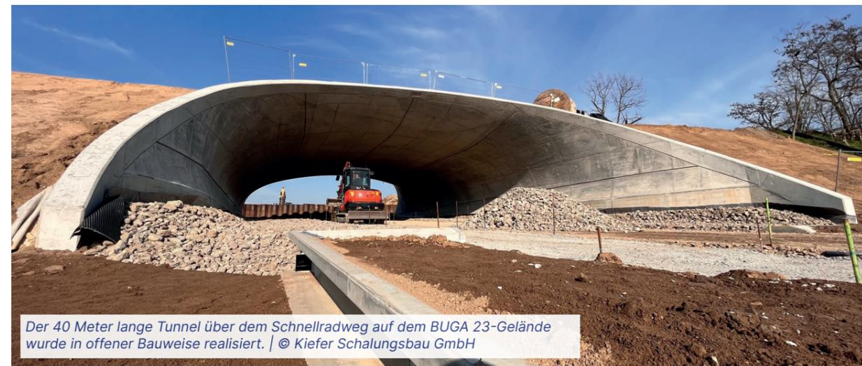
Der 40 Meter lange Tunnel über dem Schnellradweg auf dem BUGA 23-Gelände wurde in offener Bauweise realisiert. | © Kiefer Schalungsbau GmbH
