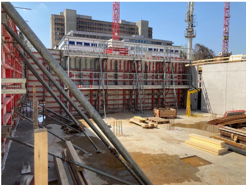
Wandschalung MEVA Mammut 350 belegt mit der alkus ® Vollkunststoffplatte. | © MEVA
