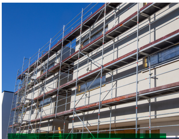
Fassadengerüst – stabile Arbeitsbedingungen für präzises und effizientes Arbeiten auf der Baustelle.
